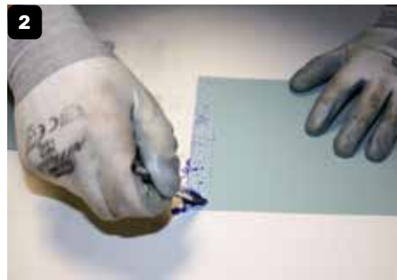
Aanbrengen van een afbijtmiddel.
