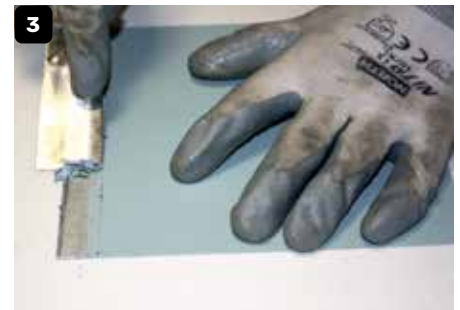
Verwijderen van de laklaag met een spatel.
