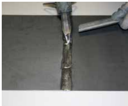
Realisatie van de gladde soldering
