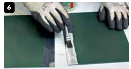
Aanbrengen van Deca VMZINC om de prepatina-laag te decaperen.
