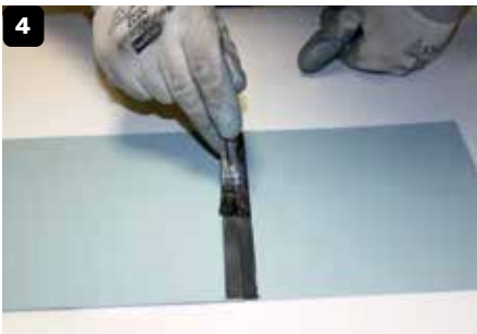
Breng plaatselijk Zinn 7 aan om goed te kunnen solderen. Breng de 2 te solderen platen samen volgens schema p 6 - 7.
