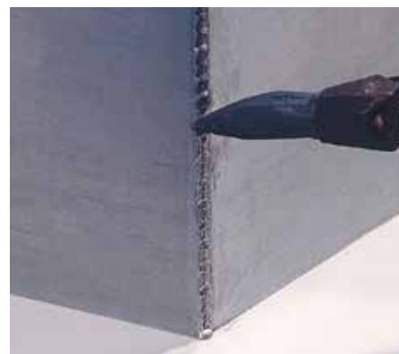
Geribde (versterkte) soldering
