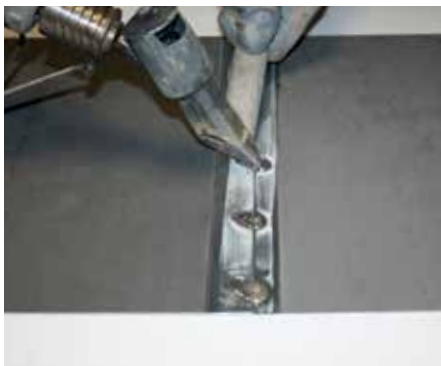
Plaatsen van de puntsolderingen
