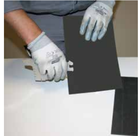
Traceren van de overlappende delen
