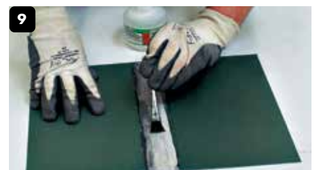
Breng plaatselijk Zinn 7 aan om goed te kunnen solderen. Breng de 2 te solderen platen samen volgens schema p 6 - 7.
